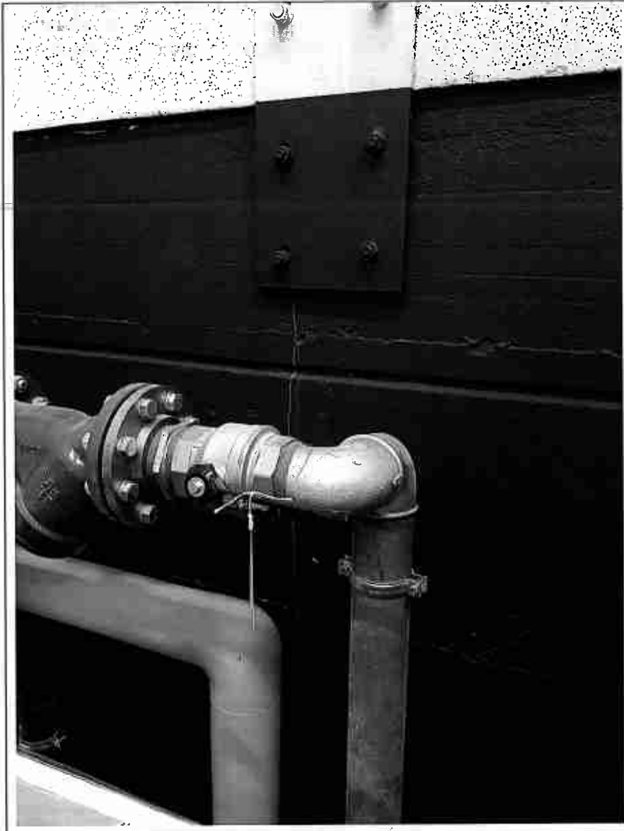
Valvole di intercettazione dell'impianto idrico del Magazzino 28
